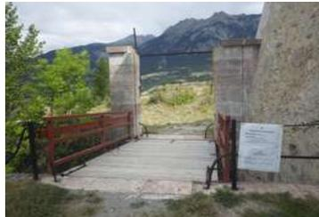
Sous le "cavalier 104", la rénovation du pont dormant est en cours et le contrepoids du pont à bascule a été démonté car dangereux, et sera remplacé au printemps.
